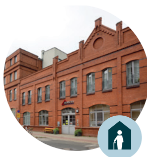
Neuendorfer Straße 75, Brandenburg an der Havel
