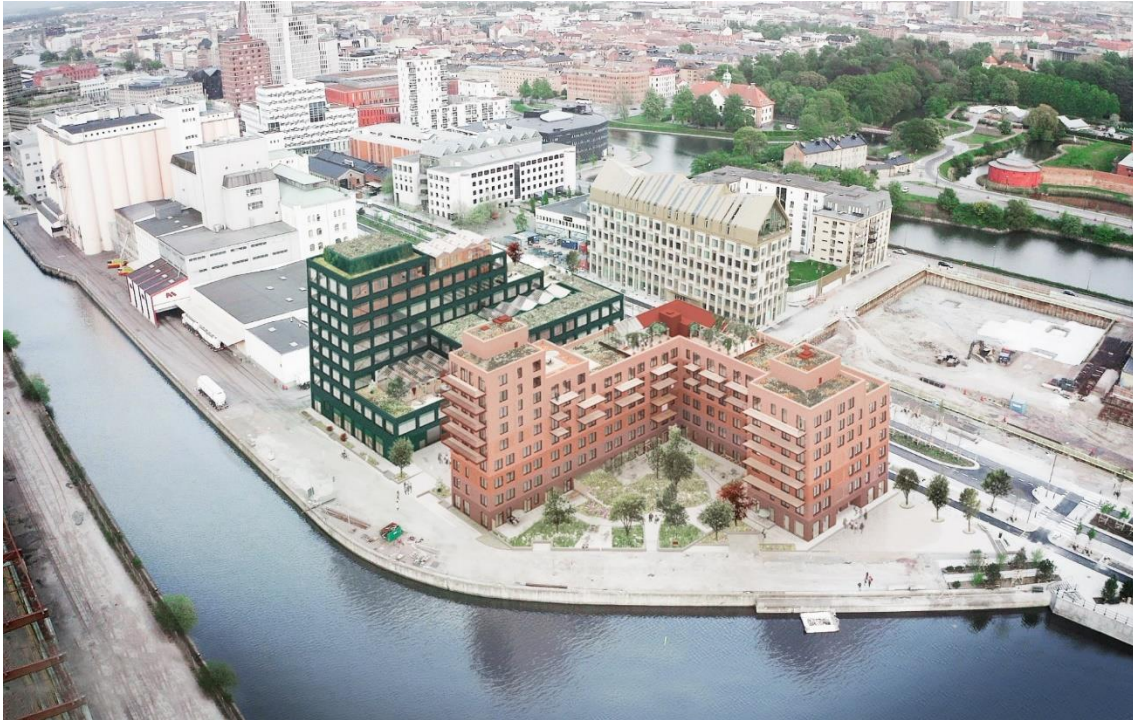
3D-fastigheten avser våning 1 - 4 i byggnaden i förgrunden
